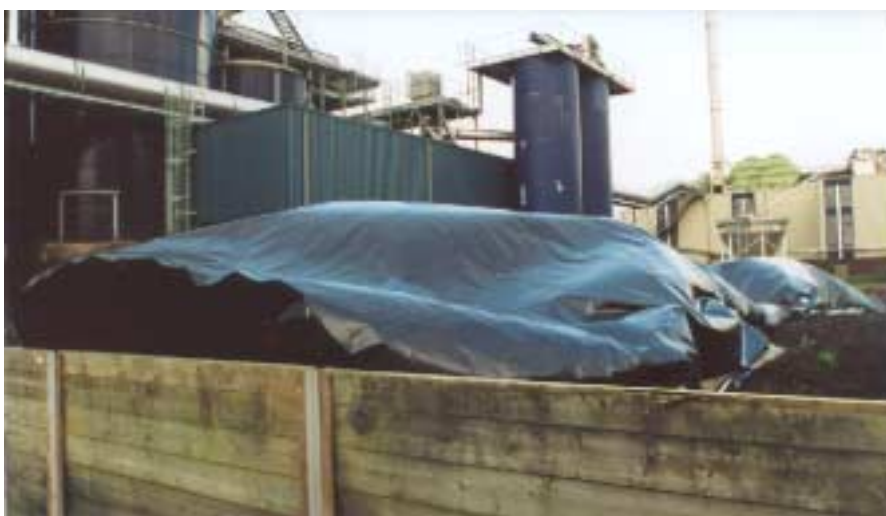
Foto 7: Biofilter met afdekmethodede
