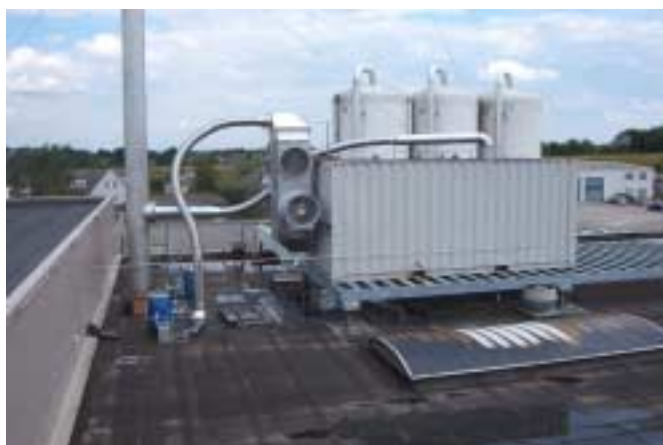
Foto 5: Ontgeuringsinstallatie
